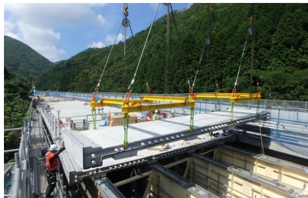
写真-1 超高耐久床版の架設
