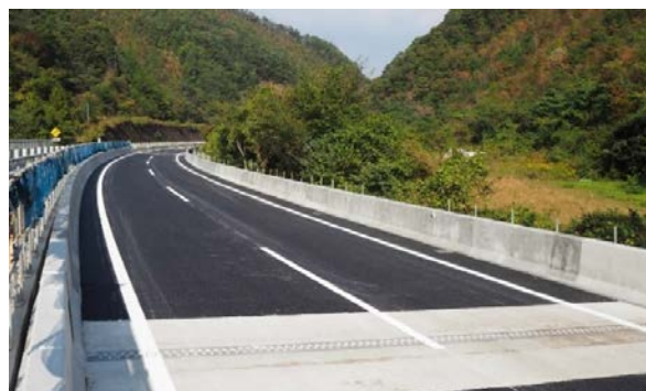
写真-2 蓼野第二橋（下り線）完成
