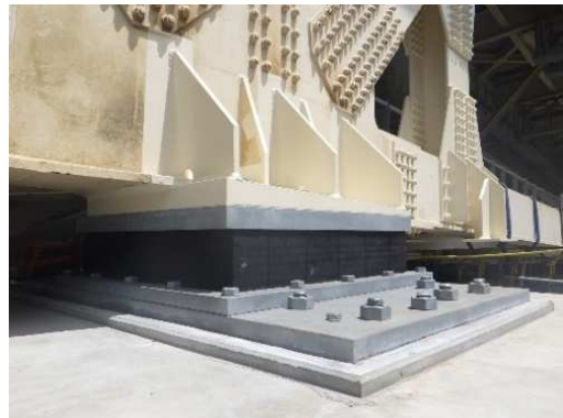
写真-5 支承受替完了後 (本名川橋 P2)
