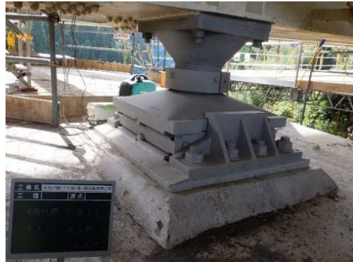
写真-3 既設支承 (本名川橋 P2)
