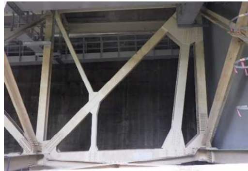
写真-4 補強材取付完了後 (本名川橋 A2)
