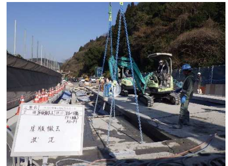
写真-2 合成桁部の主桁間床版撤去
