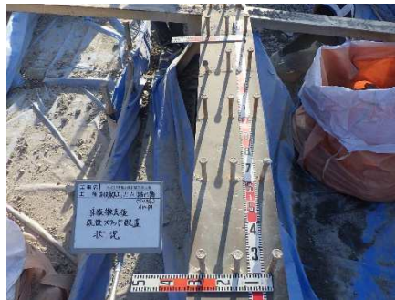
写真-1 スタッドジベル配置状況
