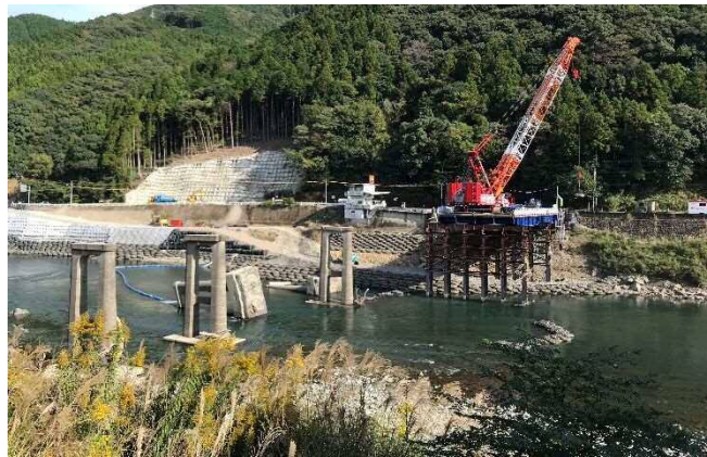
写真-1 流失した橋梁跡と仮橋の施工状況
