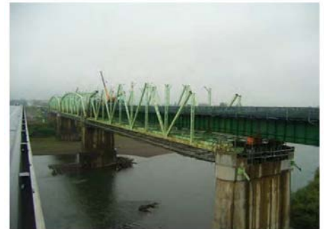
写真-1: 架設桁を用いた橋梁の解体事例 1)
