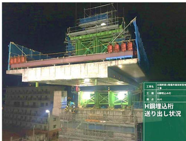
写真 2 H 鋼埋込桁架設状況
