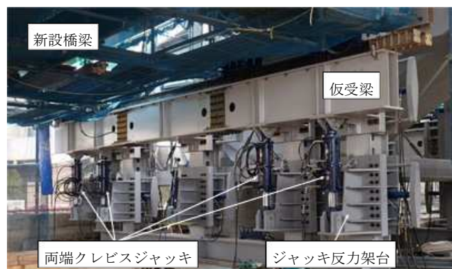
写真-2 1 次ジャッキアップ架設状況
