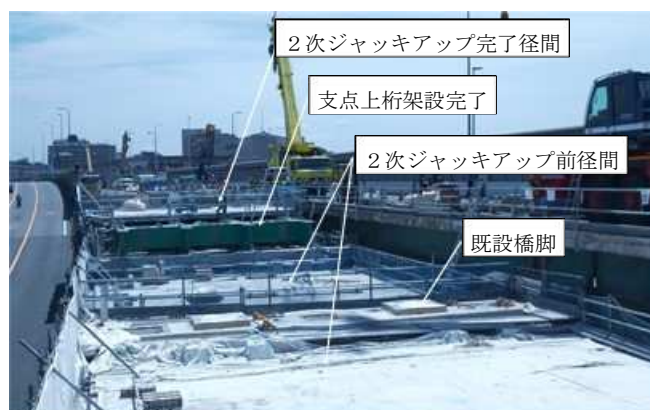
写真-3 2 次ジャッキアップ状況
