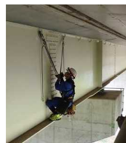
写真-2 ランヤード使用
