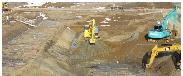
図3. ICT搭載の建機による施工
