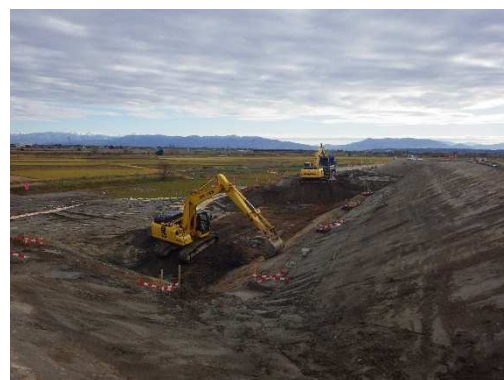
図 6. 従来の丁張設置による施工
