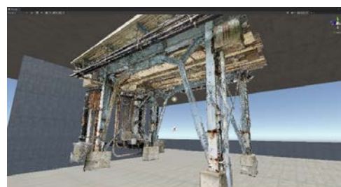
図-4 連絡通路（石川高専地内）
