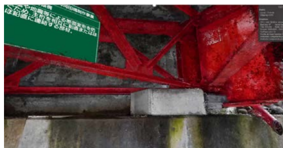
図-8 岡田橋（桁下）
