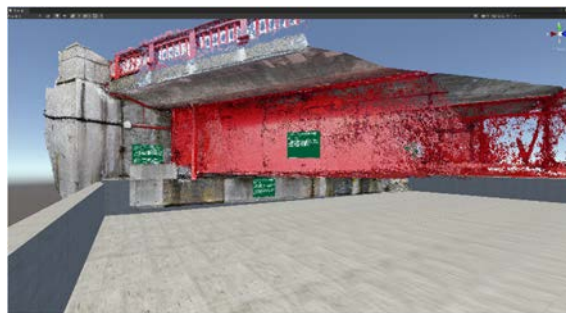
図-5 岡田橋全景
