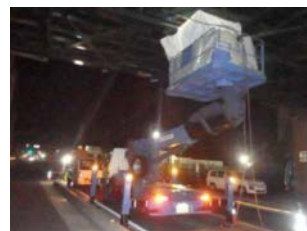
写真-4 高所作業車設置
