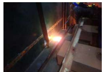
写真-5 加熱状況
