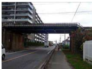
写真-1 架道橋全景
