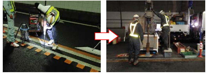
写真-3 ドリル削孔調査 写真-4 ボーリング削孔調査
