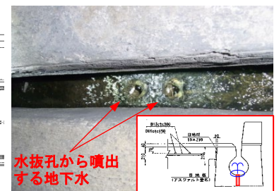
写真-2 円型水路底面の水抜き孔 (KP356.034 下り線側)
