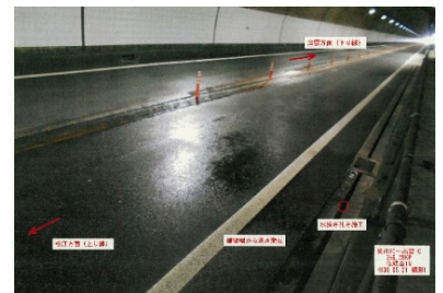
写真-1 路面滞水の状況
