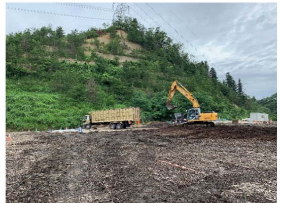
写真-5 チップ材敷設状況
