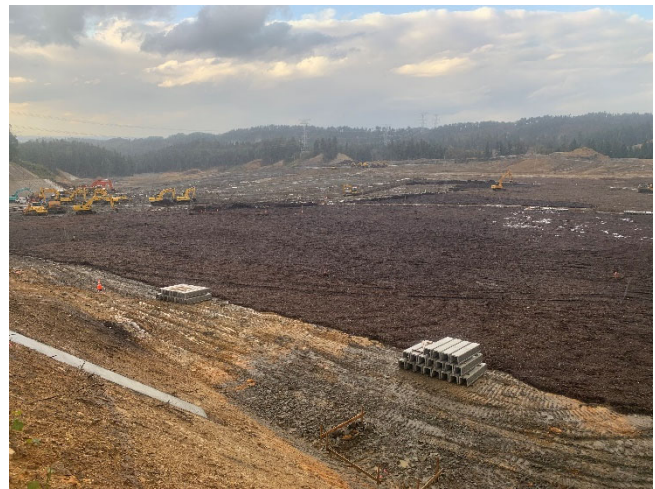
写真-1 チップ材敷設完了
