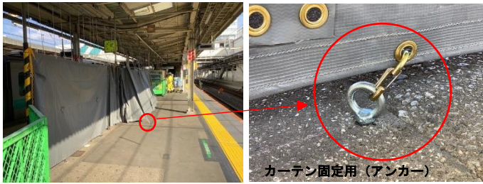
図6. 吊り下げ式カーテンの構造
