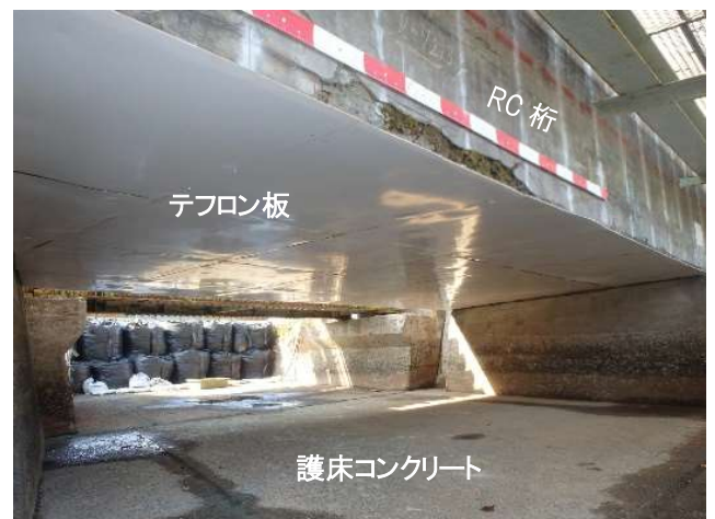
写真-1 桁下面テフロン板接着
