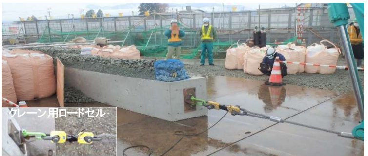
写真-3 試験施工
