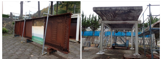
写真1 実物劣化教材（鋼桁，RC床版）
