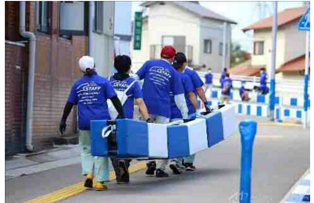
写真3 安全防護帯設置
