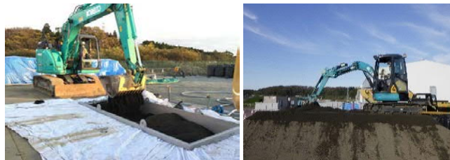
(盛土材製造状況) (敷均し状況) 図-2 試験盛土施工状況
