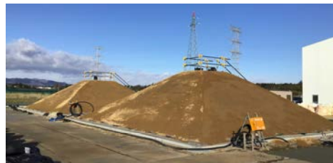
図-3 試験盛土構築完了
