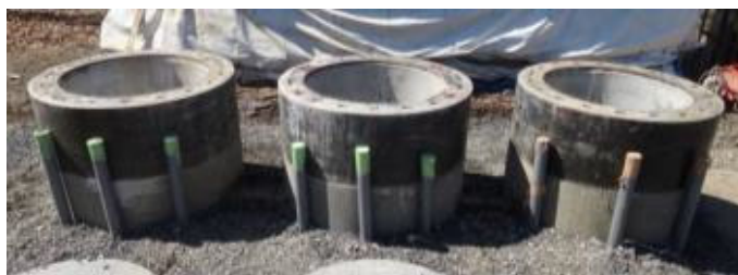
写真-2 中空円管設置完了
