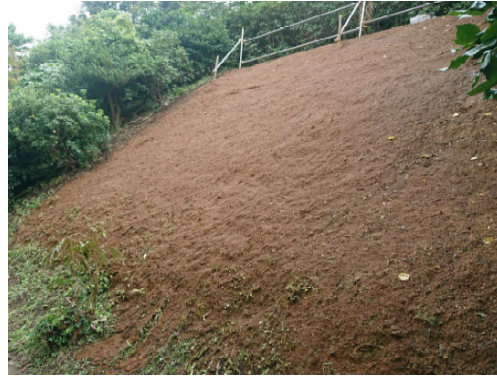
図-2 吹付け後の法面の状況
