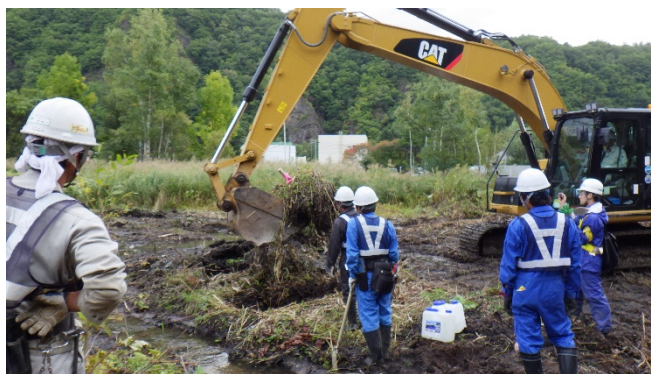
写真-1 伐り株掘り取り状況
