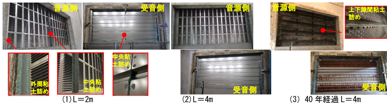
写真-2 金属製遮音板の設置方法
