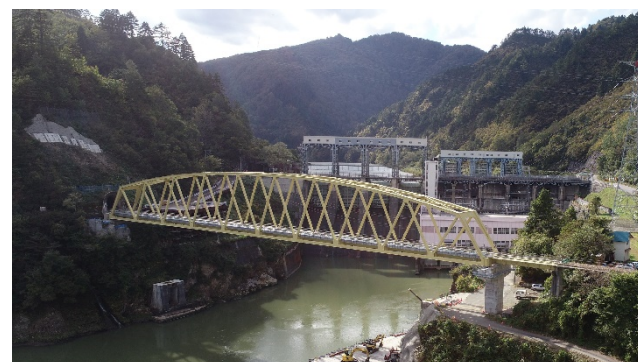
写真-2 橋りょう架設完了
