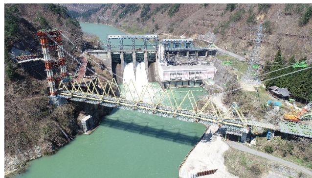
写真-1 橋りょう架設状況
