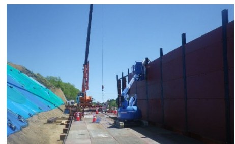
写真-3 設置状況
