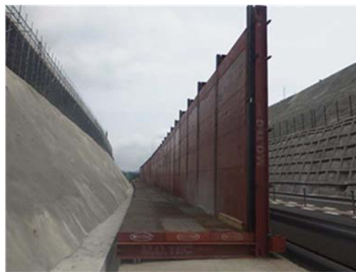
写真-3 落石防護柵設置状況
