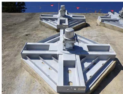
写真-4 グラウンドアンカー工
