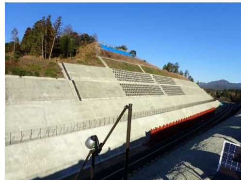
写真-1 現場全景
