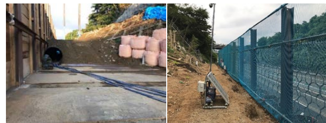
写真-5 排水切り回し 写真-6 落石防護ネット
