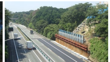
写真-3 2車線開通(8月27日)
