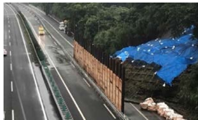
写真-2 1車線開通(7月9日)
