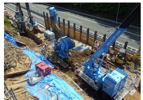
写真-7 クラッシュパイラー2 台施工
