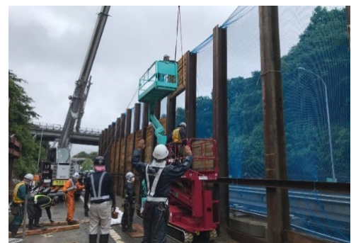
写真-8 親杭横矢板撤去状況
