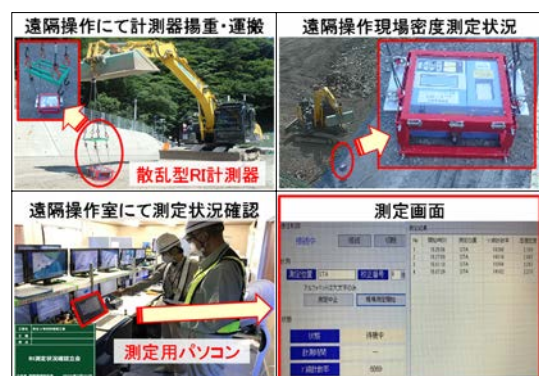
図-6 現場密度測定状況(遠隔操作室)
