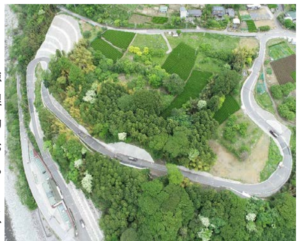
写真1 工事用道路完了全景
