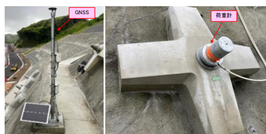
写真-4 切土法面計測器(左側:GNSS, 右側:荷重計)
