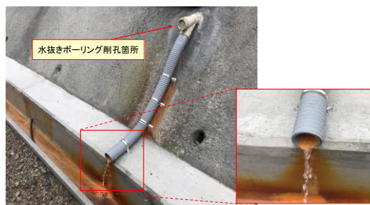
写真-3 水抜きボーリングからの排水状況
