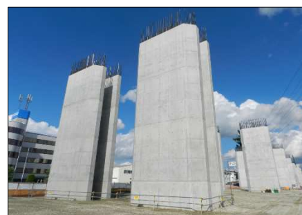
写真-2 完成写真
