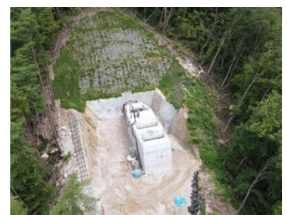
図 6 水槽全景写真
