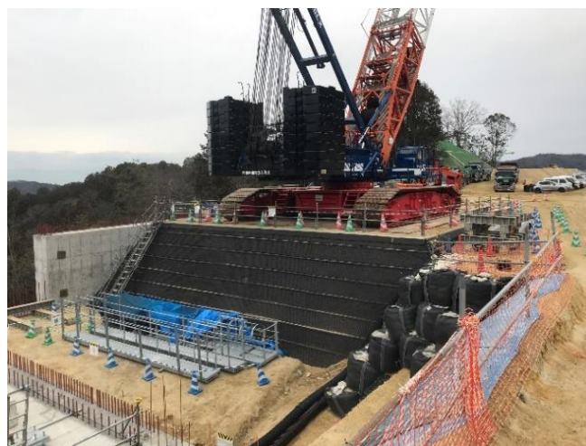
写真-1 クレーン設置状況
