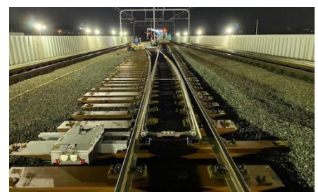
写真-1 施工完了後
