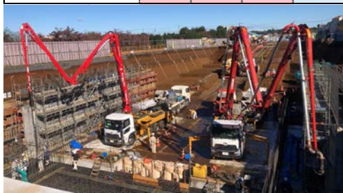
写真-2 コンクリート打設状況
