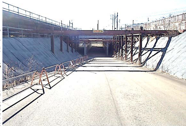
写真-1 着工前現場状況
