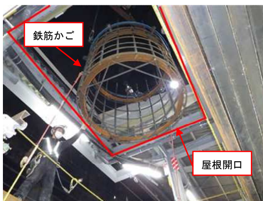
図-5 鉄筋かご搬入状況
