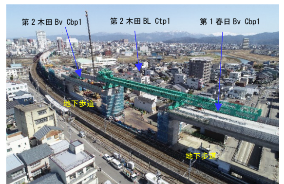
写真-3 架設桁架設(ダブルガーダー)
