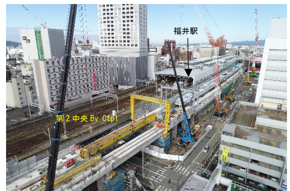
写真-1 架設桁架設方式(第2中央BvCtp1)
