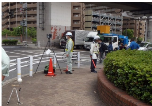
図2 定置式3DLS測量状況
