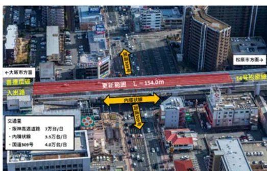
写真-1 施工位置
