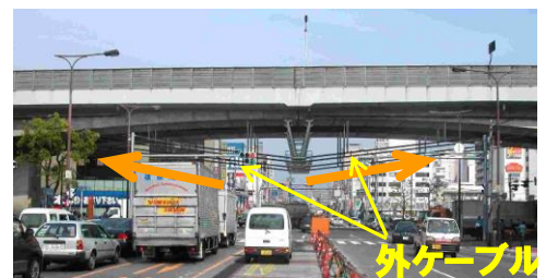
写真-1 垂れ下がり補強の状況
