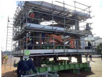
写真-3 降下設備 試験施工
