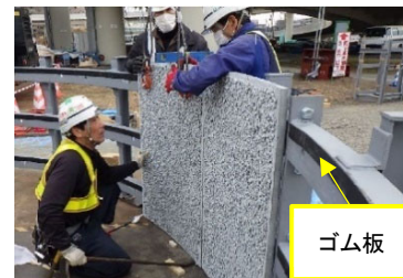
写真-3 PIC フォーム地組み状況
