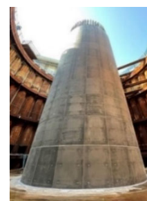
写真-6 RC 橋脚施工完了
