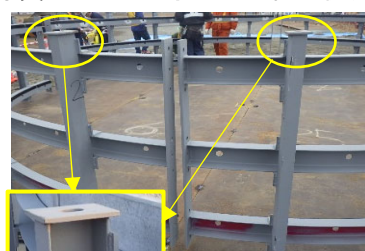
写真-4 鋼製支保工詳細
