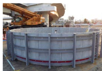
写真-1 PICフォーム地組み完了
