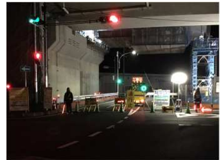
写真2 西側側道通行止め状況
