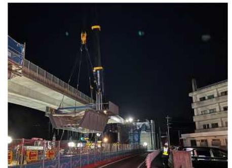
写真3 クレーン配置状況
