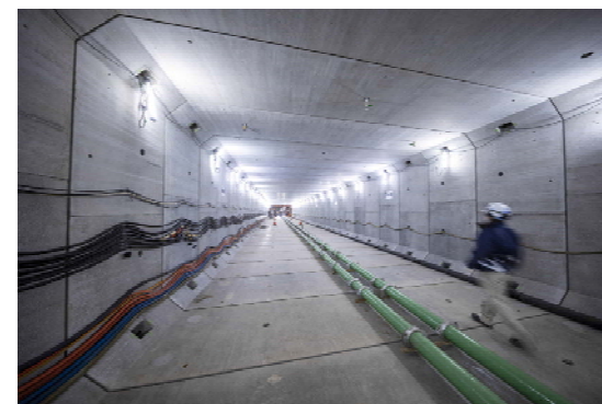
写真 3 函内施工状況
