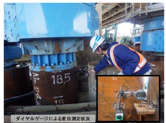
写真-1 荷重試験状況
