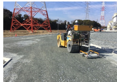
写真-4) 測定状況
