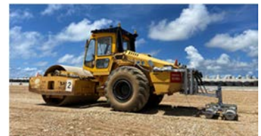
図-2 重機への搭載状況
