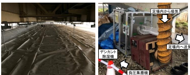
(1) 作業空間内部状況 (2) 除湿機等配置状況 図 1. 実証試験状況
