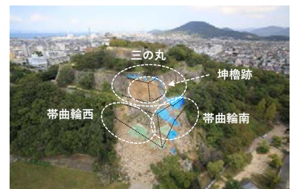
写真-1 丸亀城石垣崩落状況
