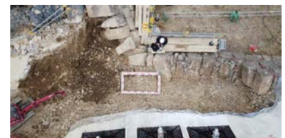
写真-2 石垣背面撮影状況
