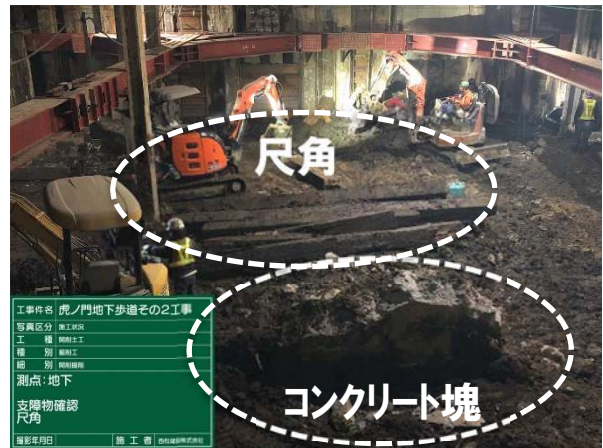
写真—2 支障物(コンクリート, 尺角)
