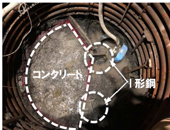
写真—3 深礎内で確認された支障物
