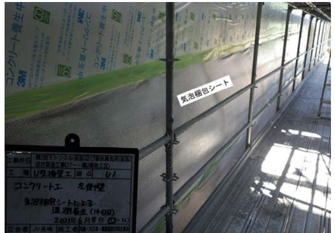
図9 気泡梱包シート設置状況写真
