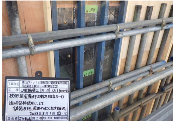
図6 透明型枠 打設状況写真
