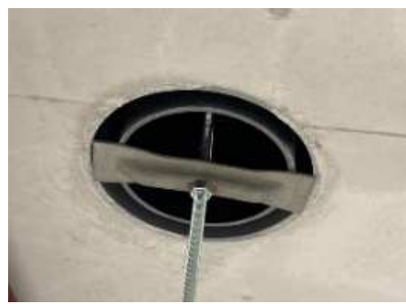
写真-4 漏水対策桝の下面
